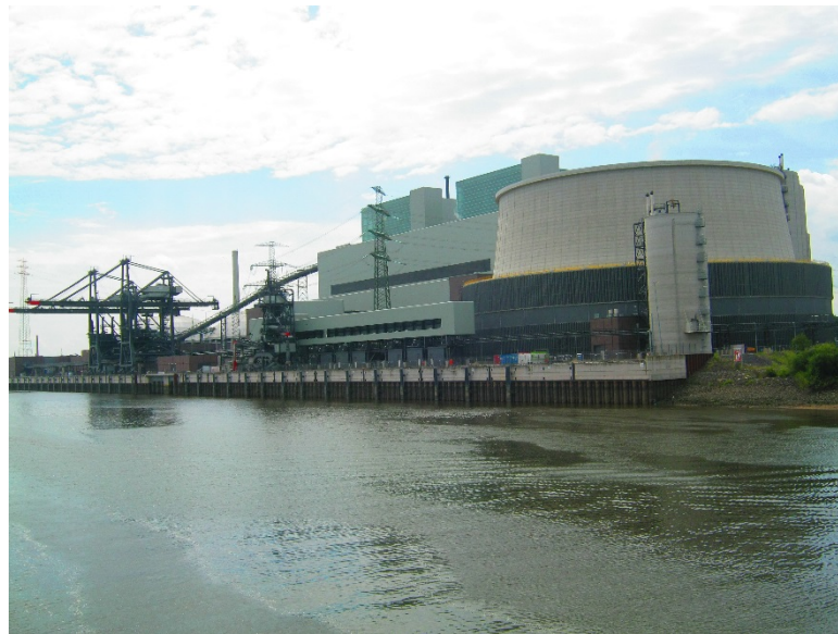
Abbildung 2: Steinkohlekraftwerk Moorburg (Quelle: Gerhard Kemme CC BY 4.0 )
